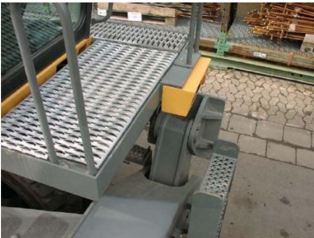
Laufroste und Aufstieg
