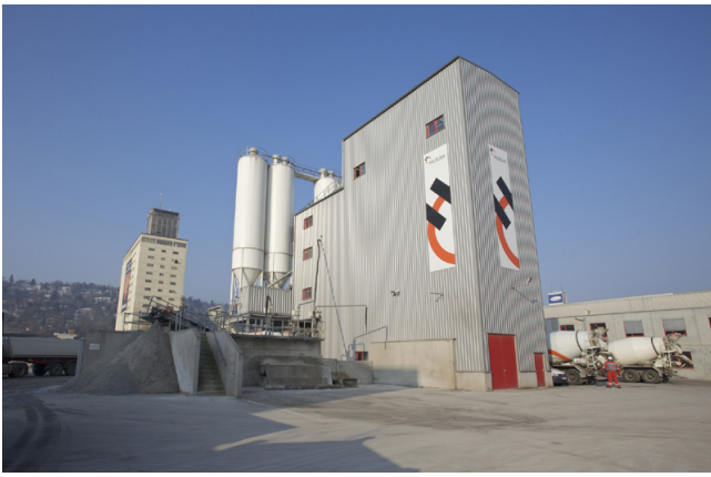
Die Holcim-Niederlassung in Stuttgart. Foto: bgrci/Plöger
