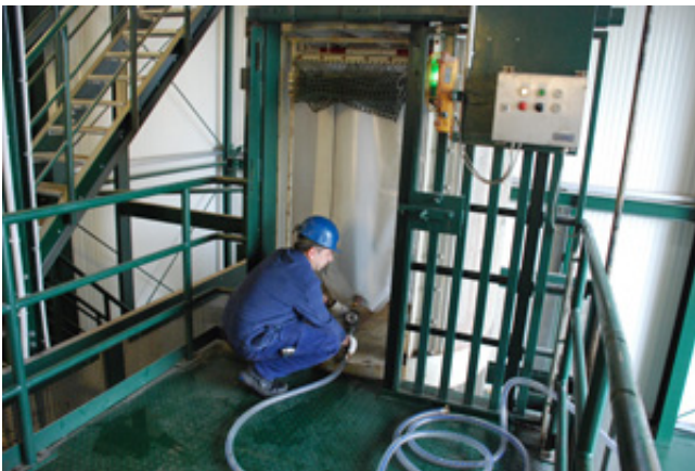
Befüllen der Wasserbehälter
