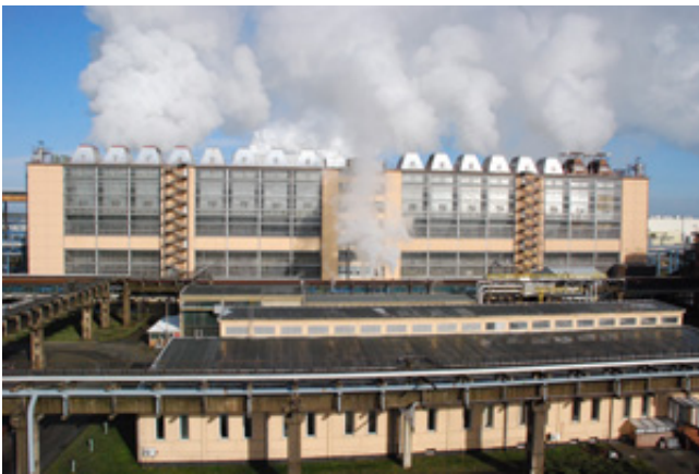
Braunkohlenveredelung Schwarze Pumpe
