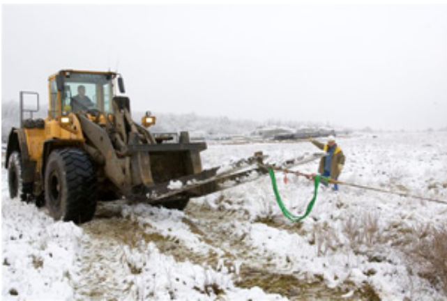
Bruchsicherung im Einsatz
