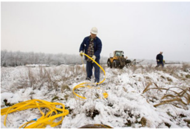
Arbeiten am Zugseil
