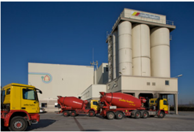
Betriebshof der peterbeton GmbH
