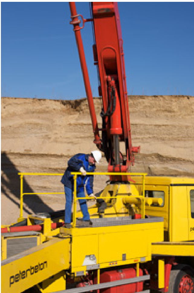
Montage der Absturzsicherung
