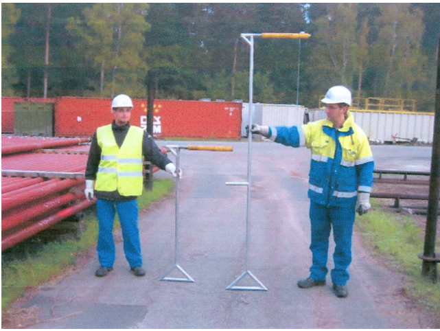
Die beiden Tools zum Rollen der Rohre.
