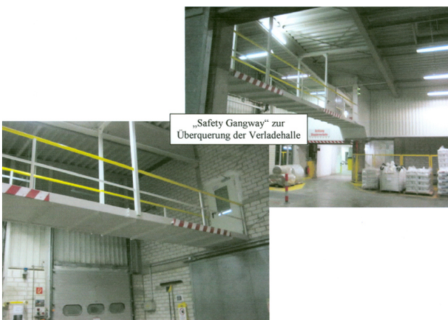
„Safety-Gangway“ zur Überquerung der Verladehalle
