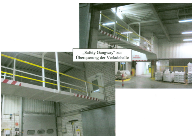
„Safety-Gangway“ zur Überquerung der Verladehalle
