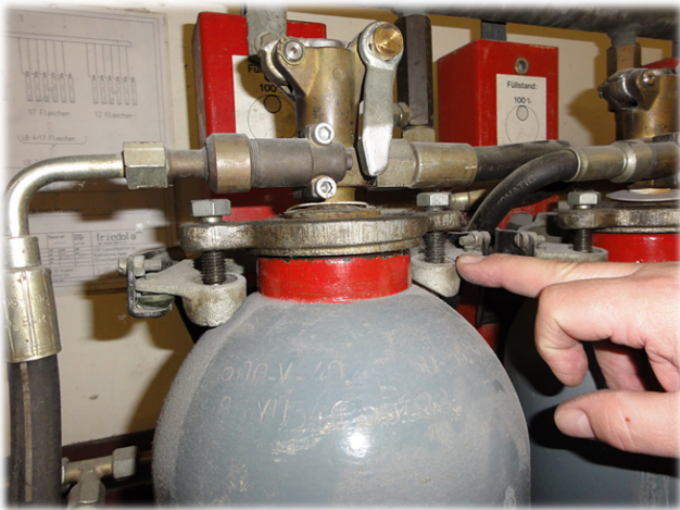
Wiegevorrichtung mit gefüllten Gasflaschen.
