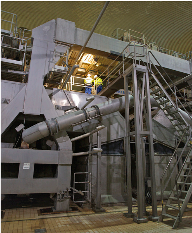
Treppen, Laufstege und Absturzsicherungen ...
