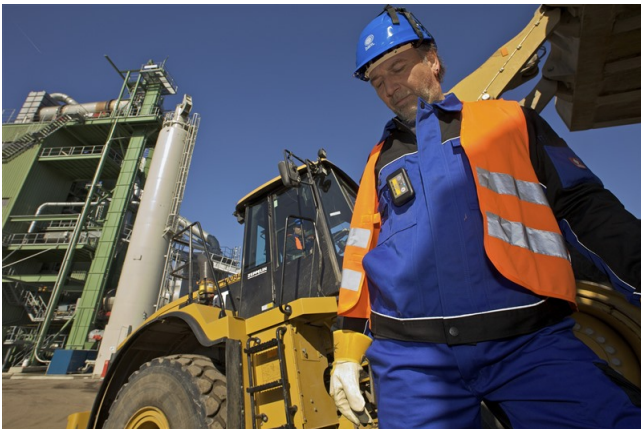
Den Beeper trägt jeder Beschäftigte, der sich im Arbeitsbereich der Erdbaumaschinen aufhält.
