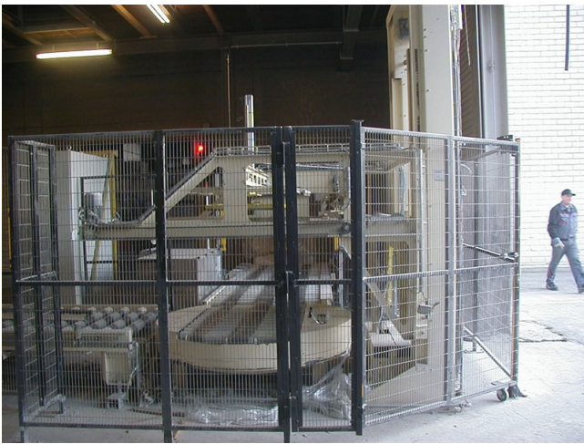
Zielposition Folienrolle: Hubrahmen für die Montage in die untere Stellung verfahren
