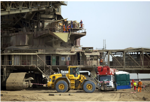
... zum Zeitpunkt von Instandsetzungsarbeiten
