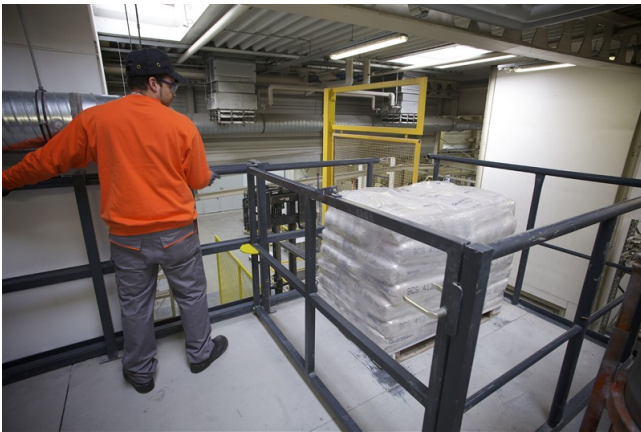
Schiebeter wird geschlossen - erst dann kann die Zugangstür geöffnet werden
