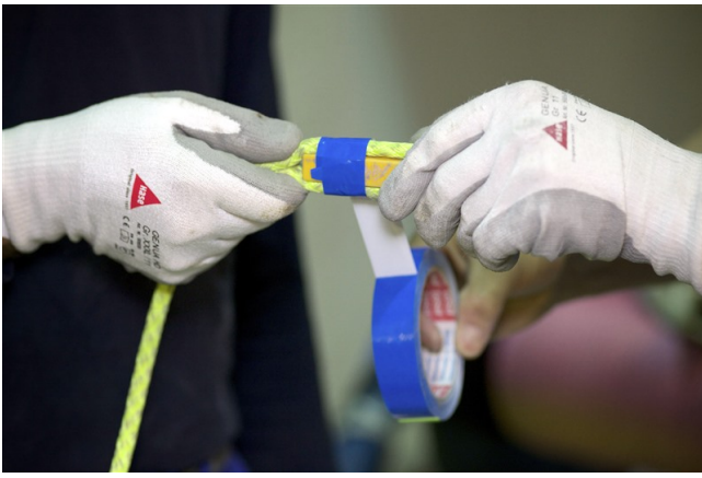
Anbringen des Aufführseils an den Magneten
