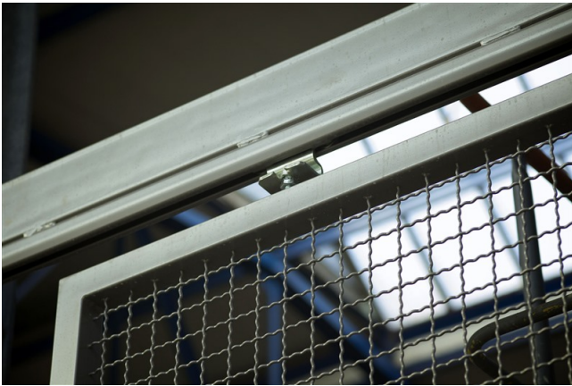
Gitteraufhängung über die gesamte Bühnenlänge
