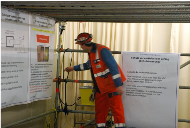
Vorführung und Erläuterungen durch Sicherheitsbeauftragten der Elektroabteilung
