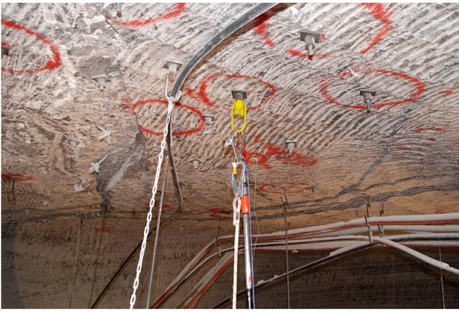
Die PSA gegen Absturz wird mit einem Karabiner eingehängt. Der herabhängende „Stöpsel“ zeigt, dass die Anschlagöse weit genug aufgeschraubt ist und sicher sitzt.
