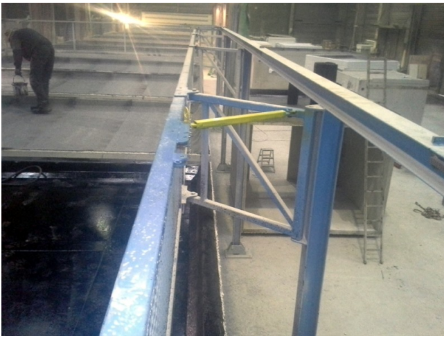
Verstellbares Geländer mit gelber Sicherungsstrebe
