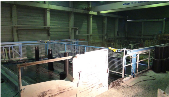
Verstellbares Geländer mit gelber Sicherungsstrebe
