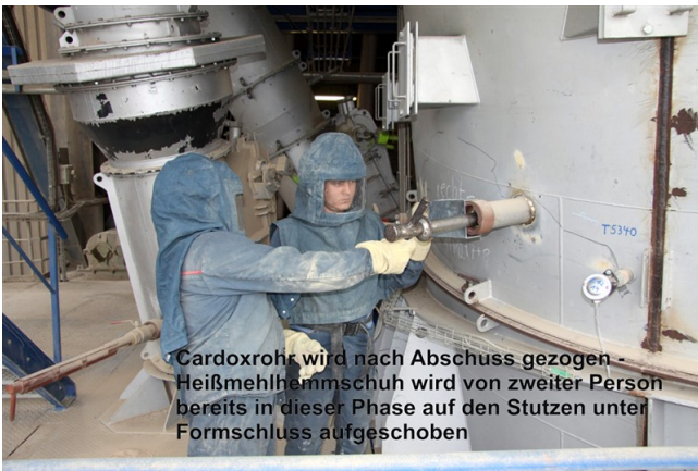
Phase 1: Ziehen, Cardoxrohr und bereits aufgesteckter Hemmschuh
