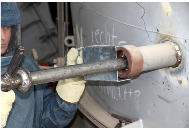
Phase 1; Ziehen, Cardoxrohr
