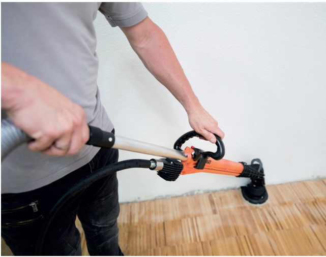
Ergoschleifer „ROKAMAT GEX P“ ermöglicht das Schleifen von Parkett im Stehen.
