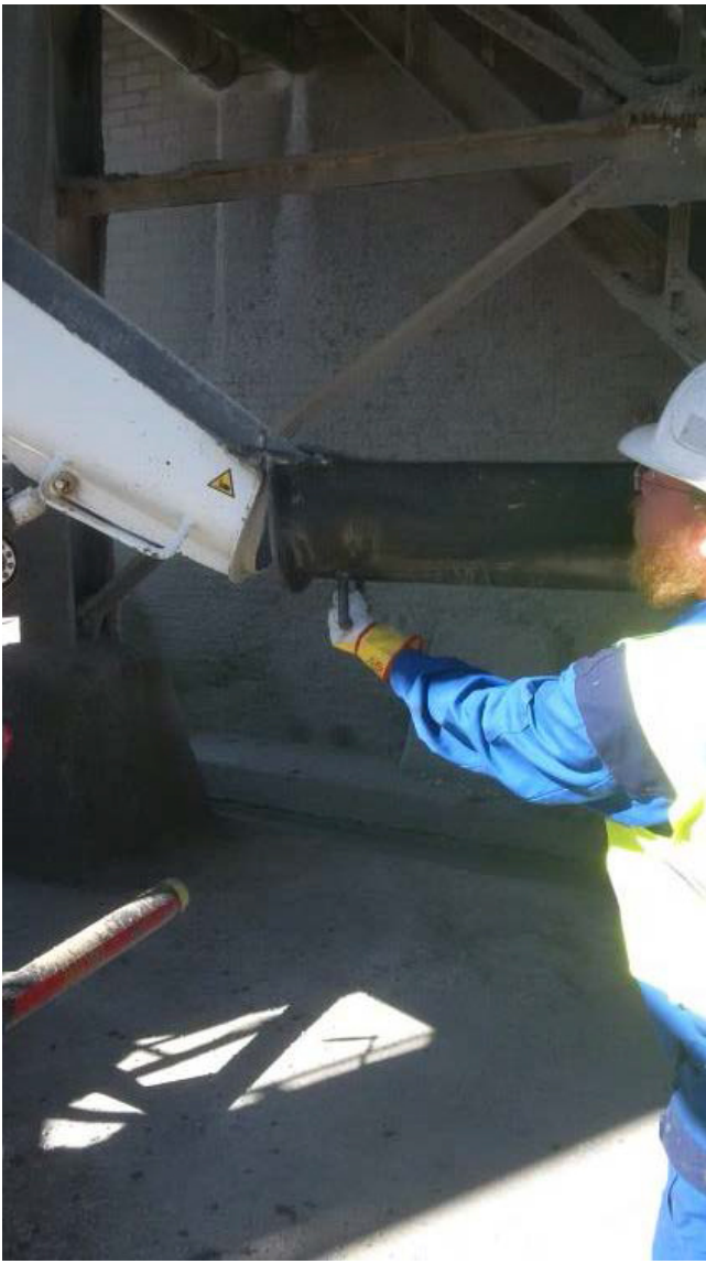
Verlängerung wird eingehakt
