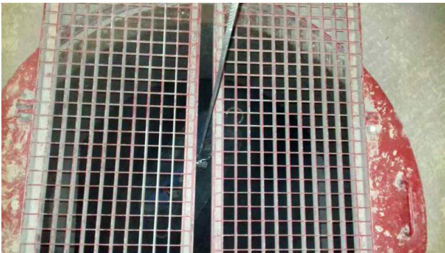
Blick von oben in das Silo - Der Seillauf ist nicht eingeschränkt
