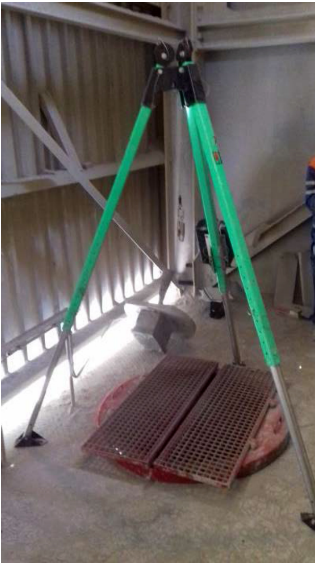
Neue Gitterrostabdeckung mit aufgebautem Dreibein
