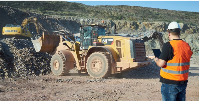
Sicherheitsmaßnahmenkontrolle auf den mobilen Baustellen.
