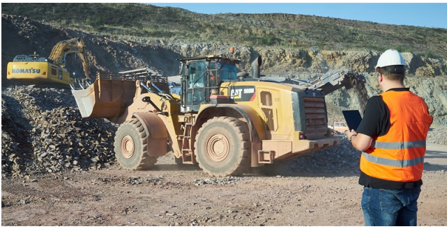
Sicherheitsmaßnahmenkontrolle auf den mobilen Baustellen.
